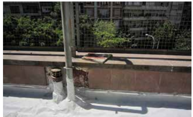
Fotos 17 y 18. Tareas de impermeabilización con membrana de pvc. Detalles de encuentros. (Fotos M J Leveratto)
