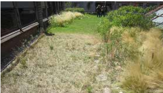
Foto 31. Sector de cubierta verde sin riego, Diciembre 2011
