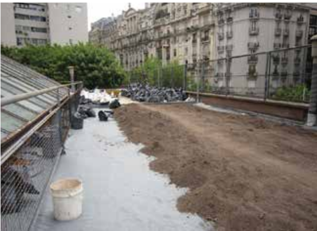
Fotos 23 y 24. Colocación de sustrato y detalle de sector rejilla. (Fotos M J Leveratto)
