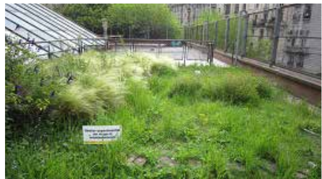
Foto 34. Sector de cubierta verde sin riego, Septiembre 2012. (Fotos M J Leveratto)
