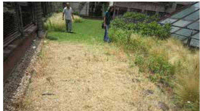
Foto 32. Sector de cubierta verde sin riego, Enero 2012
