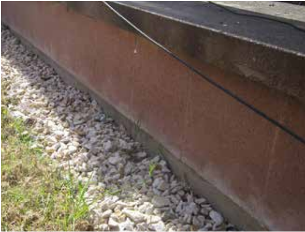
Fotos 29 y 30. Borde de piedra partida y detalle de flejes de borde y sendero. (Fotos M J Leveratto)
