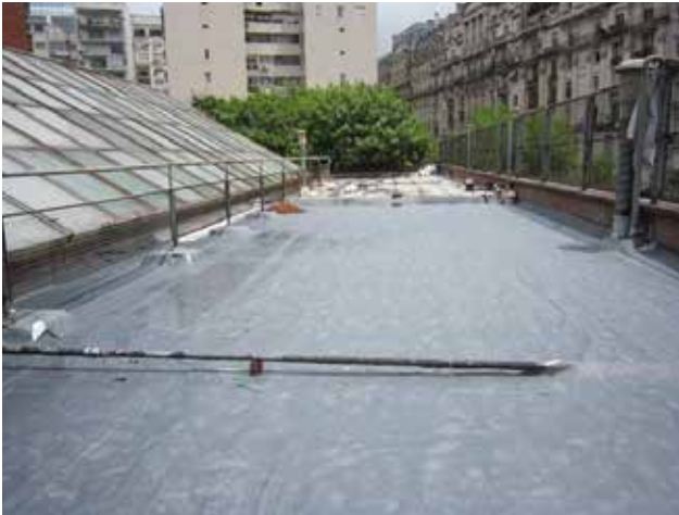
Fotos 19 y 20. Colocación de manto geotextil y de leca. (Fotos M J Leveratto)
