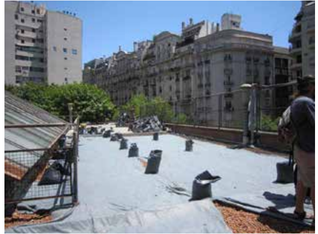
Fotos 21 y 22. Detalle de terminación de rejilla pluvial y colocación de segunda capa de manto geotextil. (Fotos M J Leveratto)
