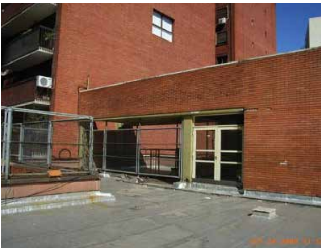
Foto 9. Superficie de terminación de terraza previo a la instalación de la cubierta verde. (Foto M J Leveratto)
