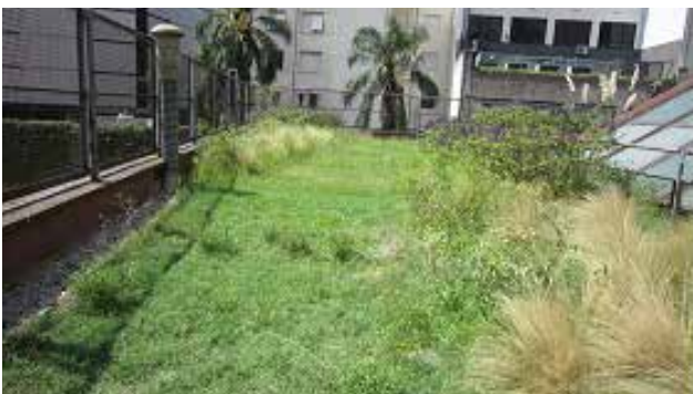
Foto 33. Sector de cubierta verde sin riego, Febrero 2012
