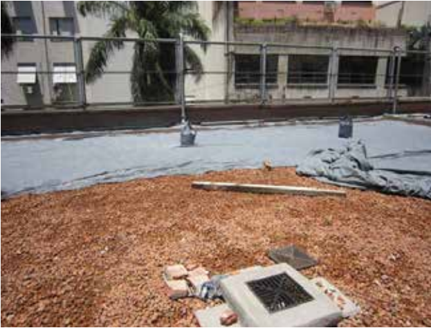
Fotos 21 y 22. Detalle de terminación de rejilla pluvial y colocación de segunda capa de manto geotextil. (Fotos M J Leveratto)
