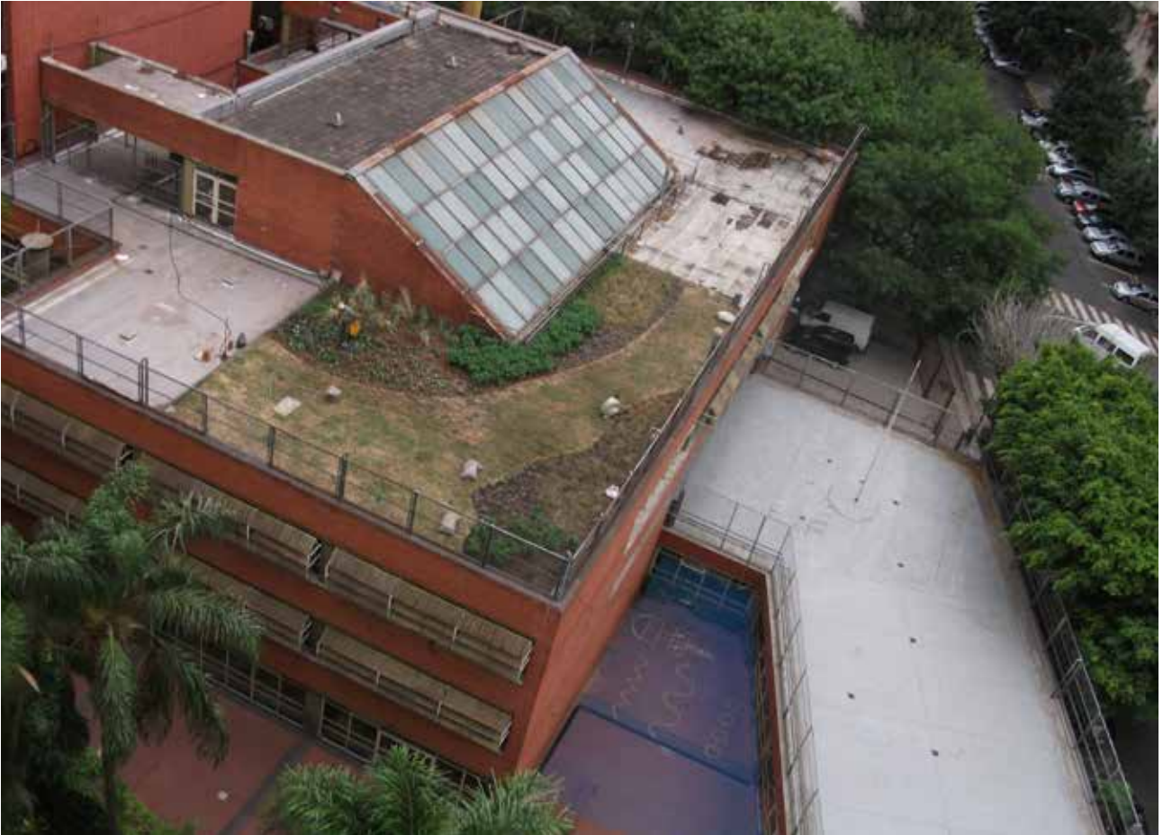
Foto 4. Vista de la escuela Nro. 6 con la cubierta verde instalada. (Foto: G Fiallo Montero)
