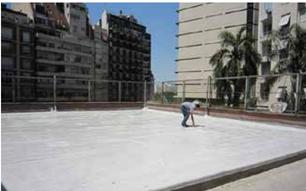
Fotos 17 y 18. Tareas de impermeabilización con membrana de pvc. Detalles de encuentros. (Fotos M J Leveratto)
