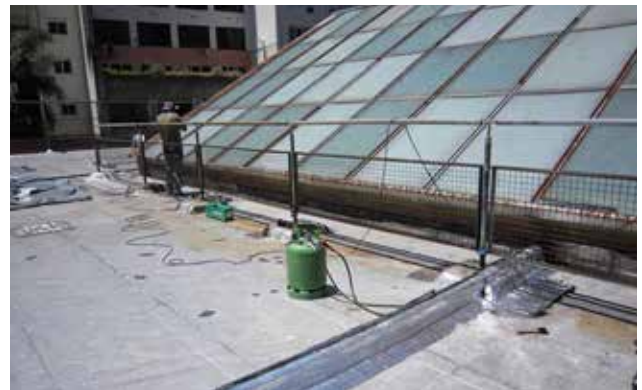
Fotos 15 y 16. Tareas de impermeabilización con membrana de PVC y detalles de encuentros con membrana asfáltica. (Fotos M J Leveratto)
