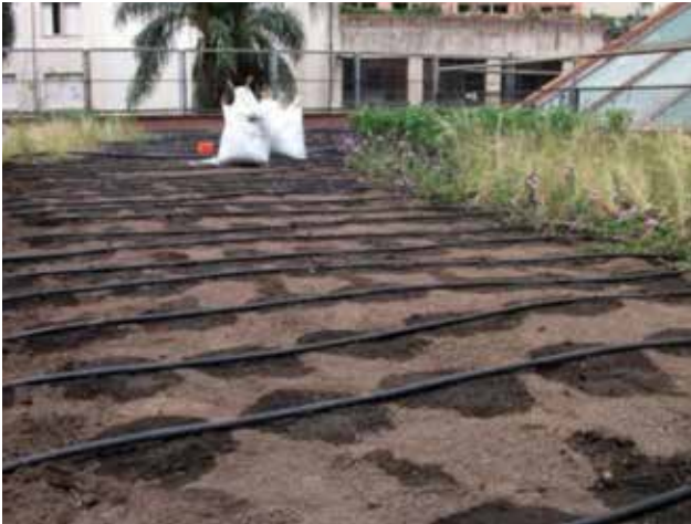
Fotos 25 y 26 Sistema de riego por goteo con sistema controlador automático. (Fotos M J Leveratto)
