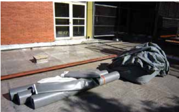
Fotos 15 y 16. Tareas de impermeabilización con membrana de PVC y detalles de encuentros con membrana asfáltica. (Fotos M J Leveratto)
