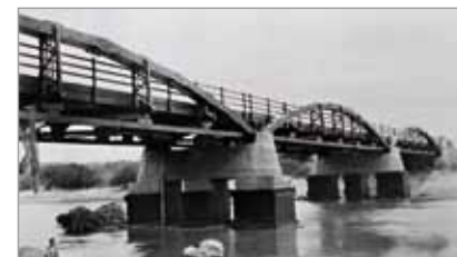
Puente de madera sobre el Río Juramento
