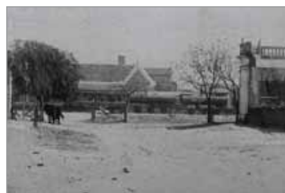
Estación de ferrocarril - Frías
