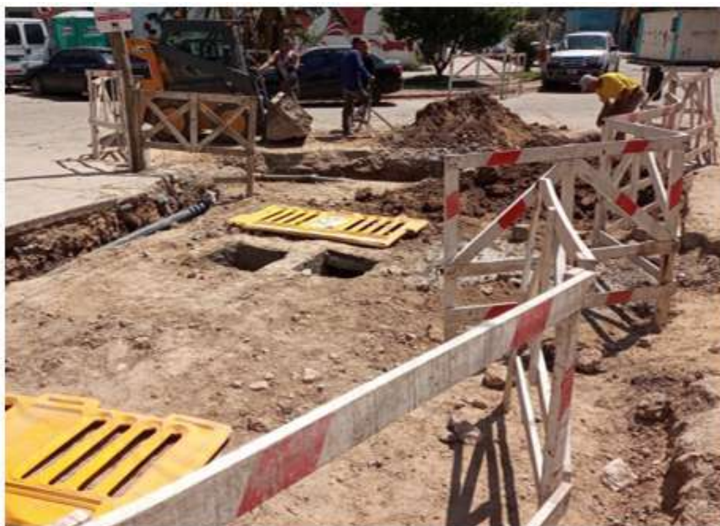
Adecuación de Cámaras existentes
