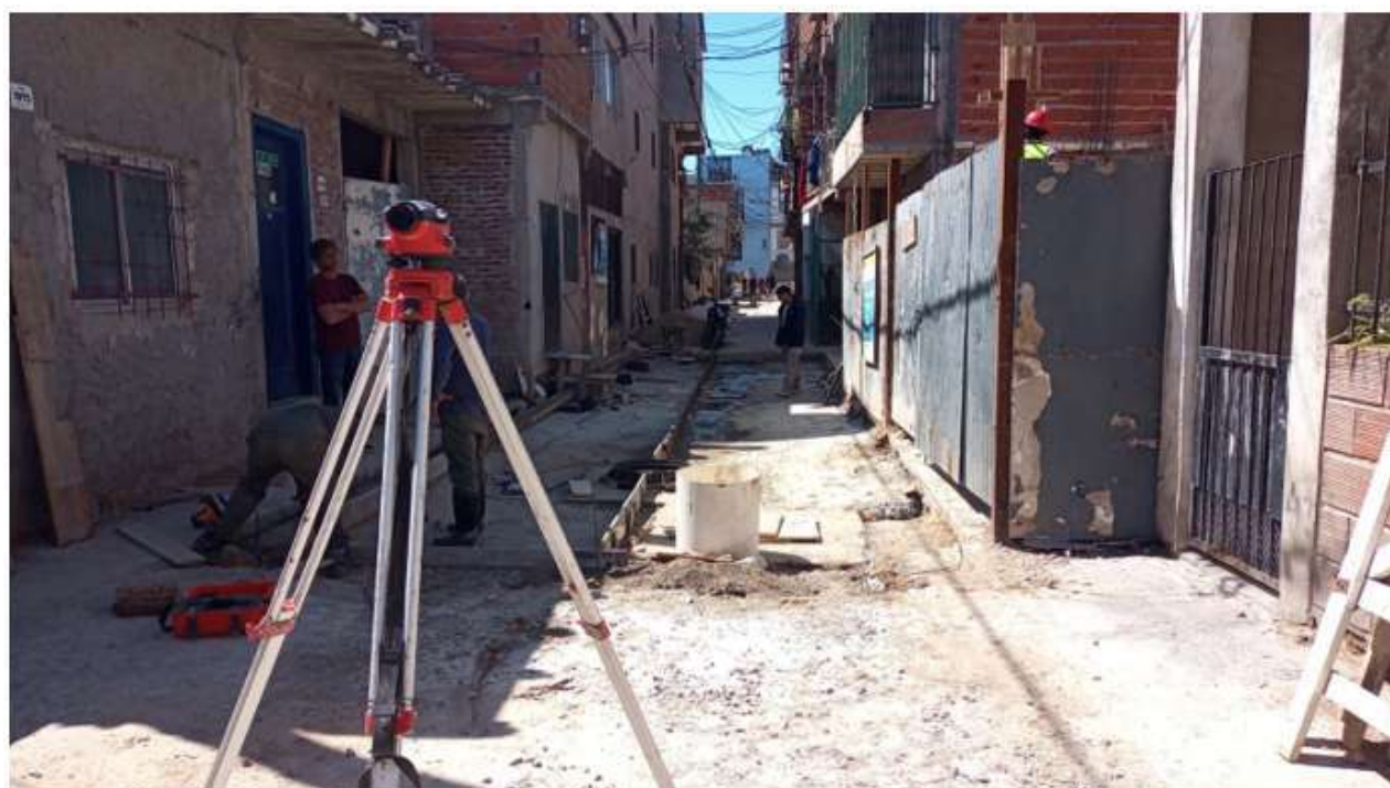
Preparación para ejecución de llenado de hormigón
