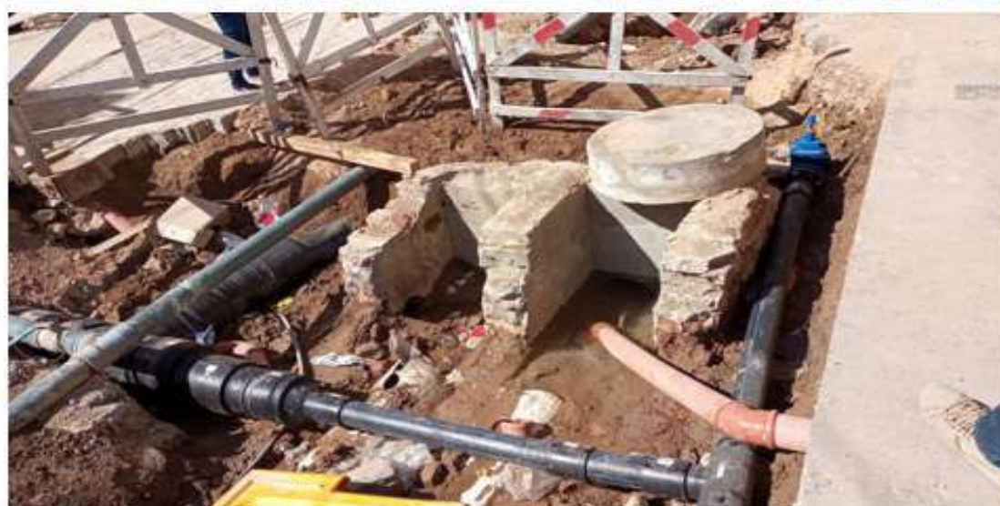
Ejecución de empalme y tendido de cañerías de Agua
