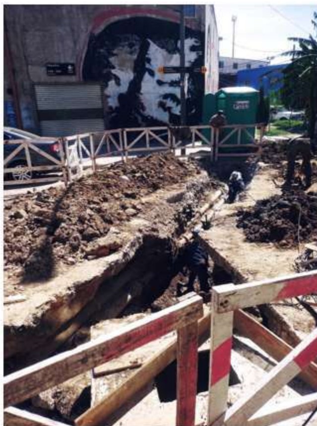
Ejecución de zanja para cruce de vereda en Mapuches
