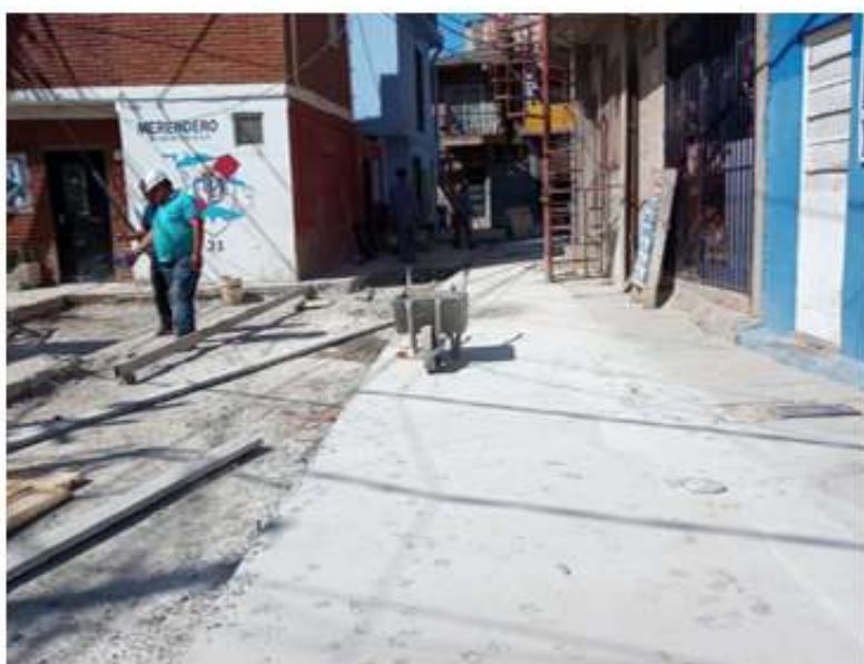
Ejecución de pavimento de hormigón en Talampaya entre Evita y Mapuches
