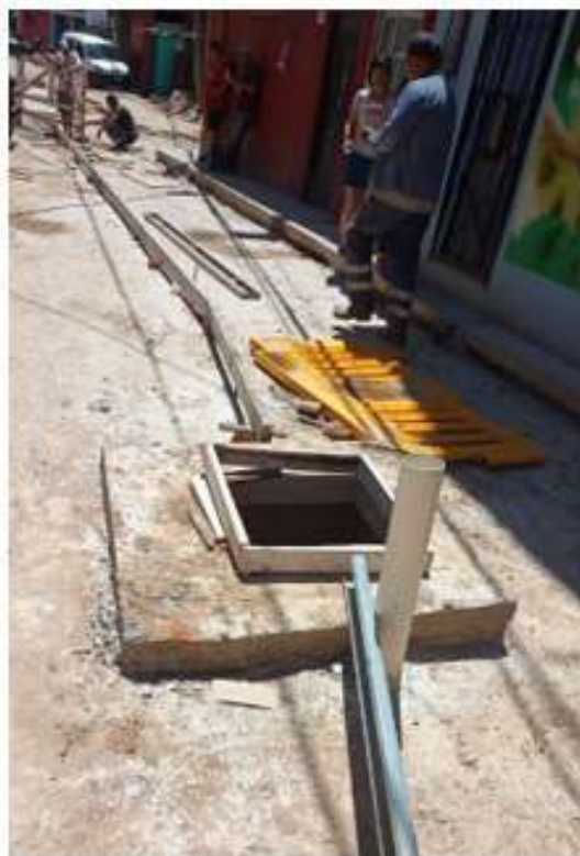
Ejecución de tendido de cañería cloacal y Boca de Registro sobre Talampaya
