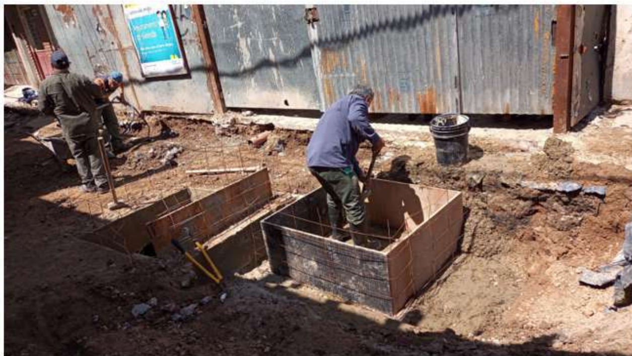
Ejecución Bocas de Registro Cloacal y Pluvial
