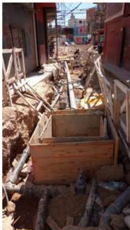
Ejecución de tendido de cañería cloacal y Boca de Registro sobre Talampaya
