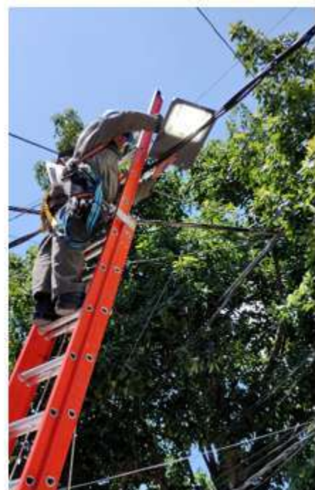
Colocación de luminarias
