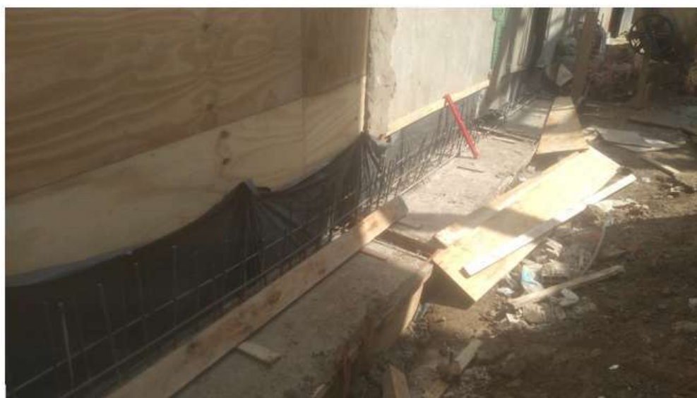
Ejecución del muro de contención norte
