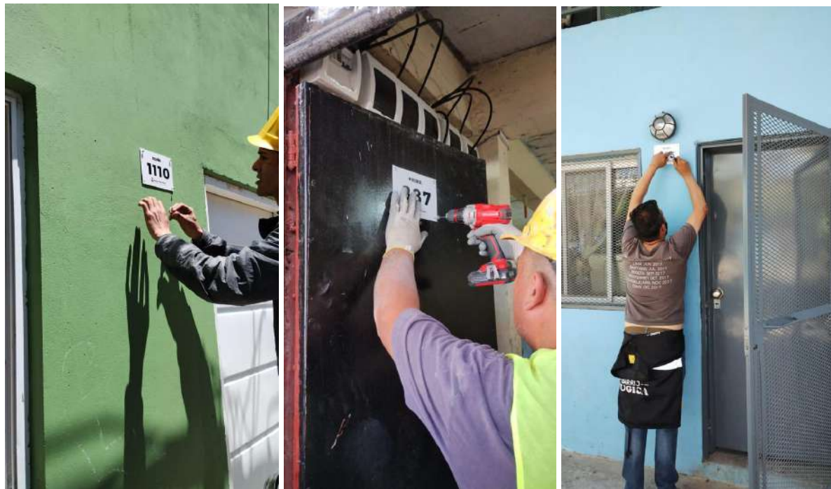
Imágenes de las jornadas de instalación de chapas pendientes
