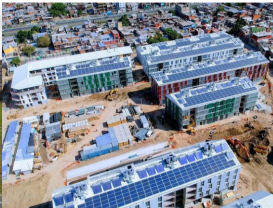
Figura 34: Instalaciones de termotanques solares y módulos fotovoltaicos en el Barrio 31.
