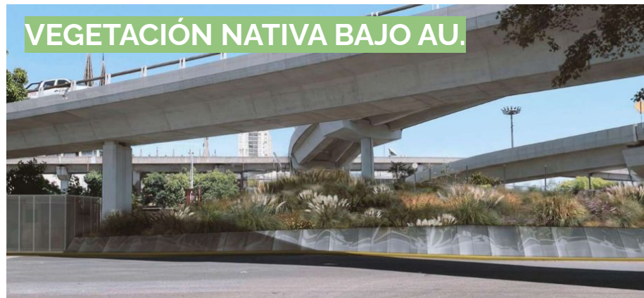
COMPLETAR GUARDARRAIL Y VEGETACIÓN
