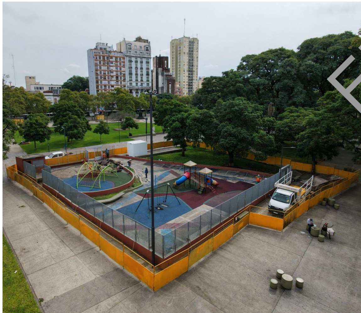
Imagen aérea: obra iniciada
