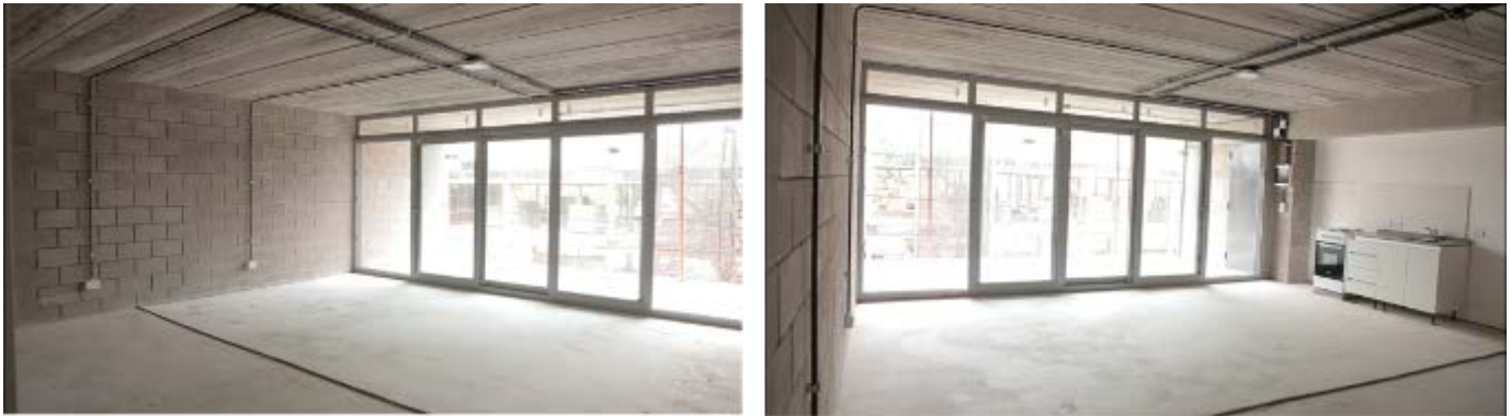
Imagen 19. Fotos de la vivienda modelo dentro de la obra de YPF en proceso.
