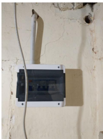
Caños y Tableros instalados con Protecciones Eléctricas
