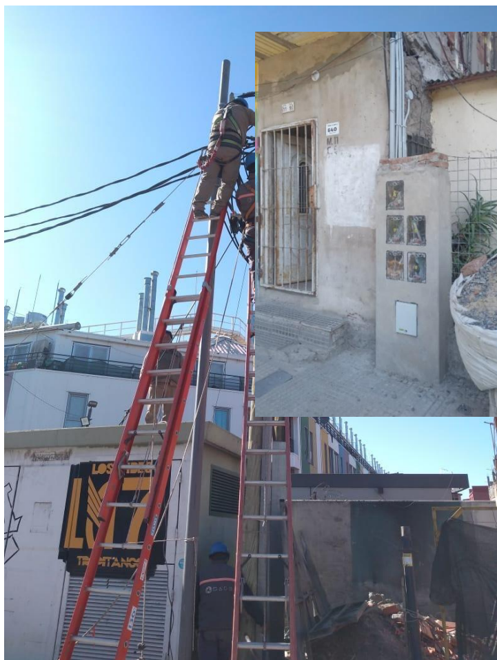
Tendido de nuevos cables de Distribución
