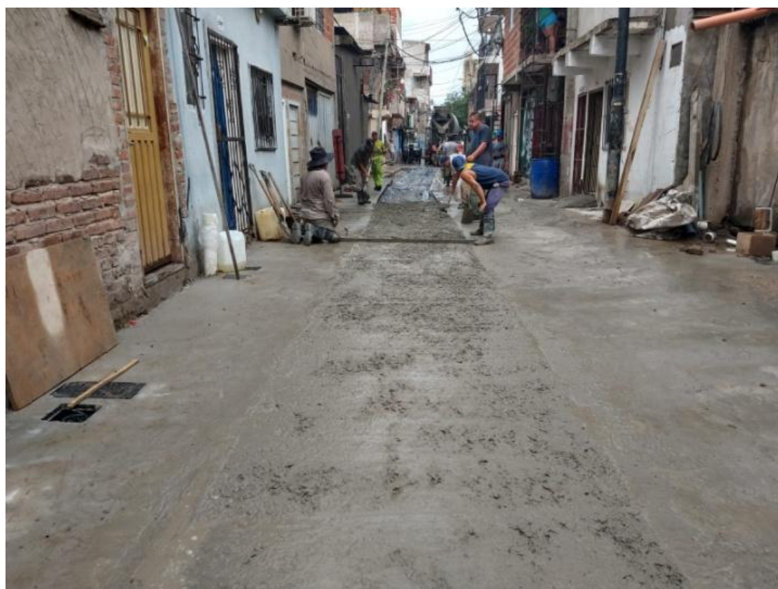
Ejecución de pavimento y veredas en Hormigón en Calle Evita
