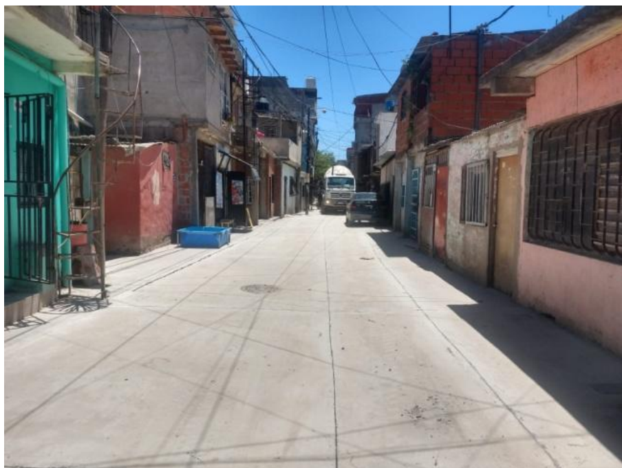
Pavimento y veredas de hormigón terminados en el primer tramo de Calle Evita
