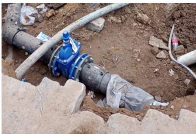
Válvula esclusa sobre cañería de agua en esquina Talampaya
