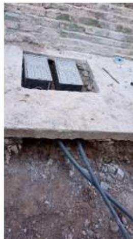
Ejecución de conexiones domiciliarias de agua
