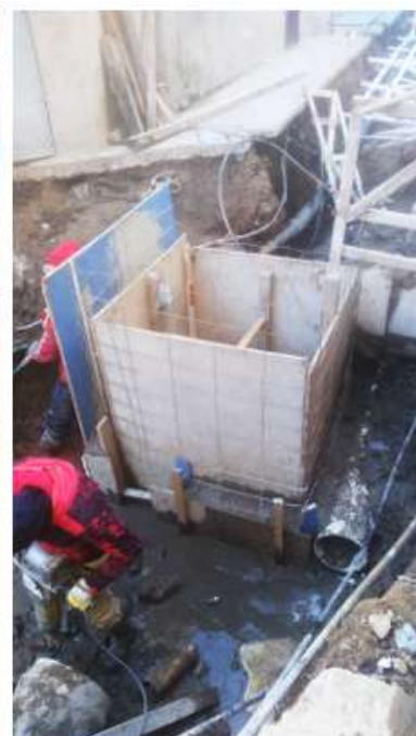
Ejecución de Bocas de Registro pluvial y cloacal
