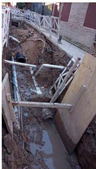
Tendido de caños pluvial y cloacal
