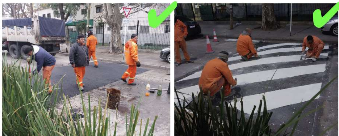
Ejecución del reductor de velocidad
