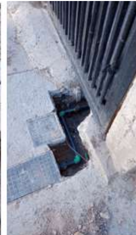
Ejecución de conexiones domiciliarias de agua
