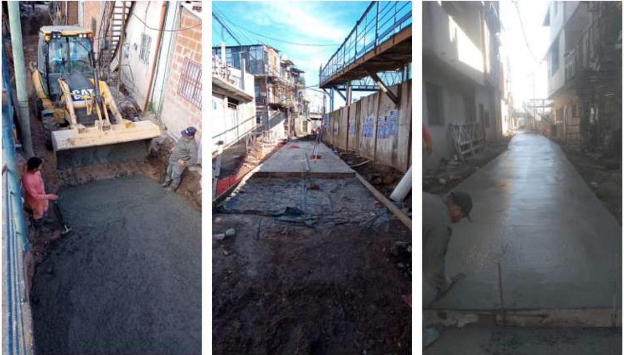
Ejecución de pavimento y veredas de hormigón en Chejolán Norte
