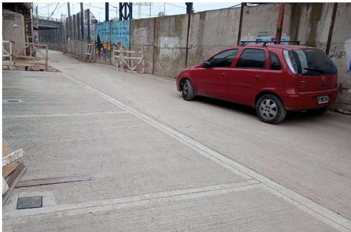
Pavimento y veredas de hormigón terminadas en esquina de Chejolán y Mbaracayú
