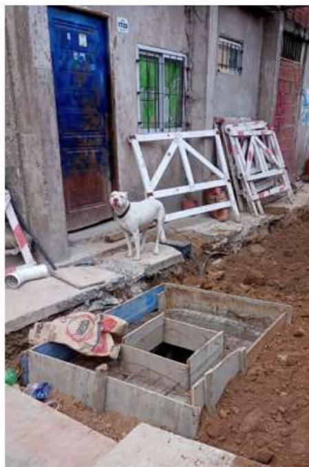
Ejecución de Bocas de Registro pluvial y cloacal
