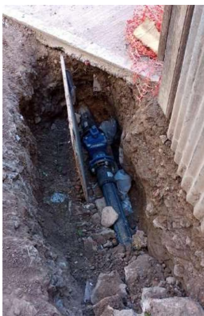
Colocación de válvula y cañería de agua
