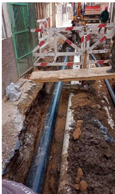
Tendido de cañerías (agua, cloaca y pluvial)
