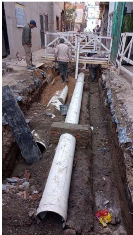
Tendido de cañerías (agua, cloaca y pluvial)
